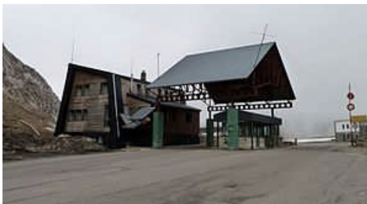
Ancien poste frontière du col du Pourtalet (Photo : Wikipédia)
